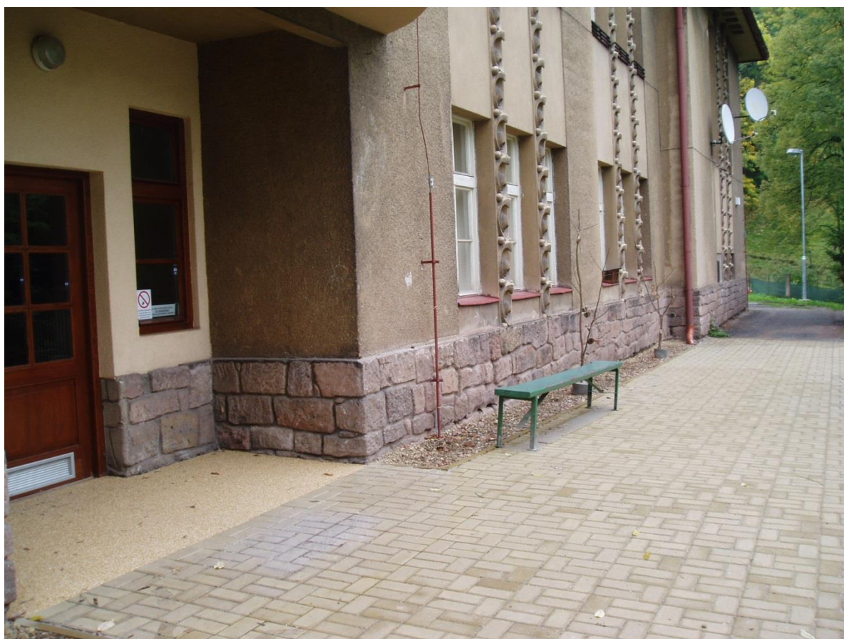
Výtvarná učebna – bezbariérový vstup
